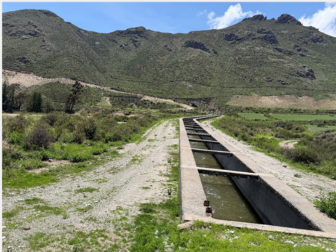
Foto 1. Infraestructura del canal del Proyecto Especial Majes-Siguas (PEMS), que trasvasa el agua desde la zona altoandina hacia las pampas desérticas de Majes.
